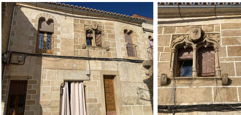
Casa de los Pereros con su ventana geminada
