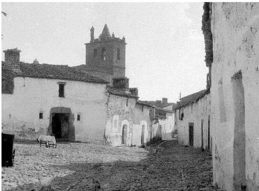
Plaza de Fraguas, donde se aprecia la fachada con sus ventanas pequeñas de la posible sinagoga en la Judería garrovillana (Foto - E. Bravo)
