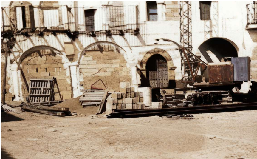
Arreglo y construcción de los portales de la parte alta de la Plaza Mayor
