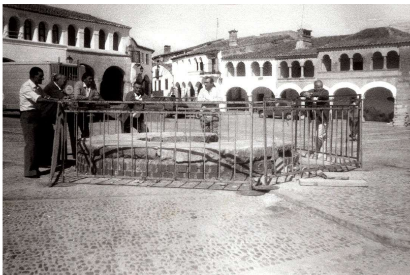
Reconstrucción del pozo, la columna y la fuente o cañería en el año 1991
