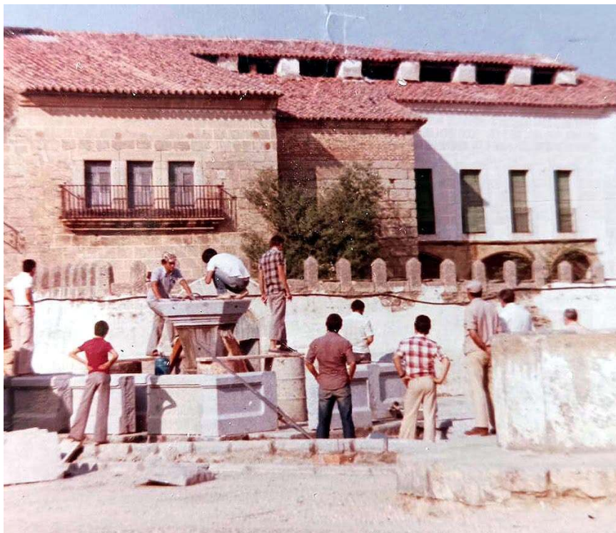
Construcción de la fuente nueva en la Pla Mayor de la Constitución
