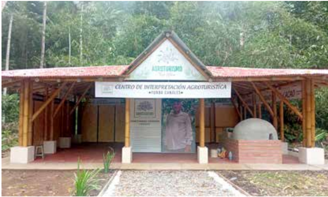
Figura 6. Construcción de bungalow inicial
