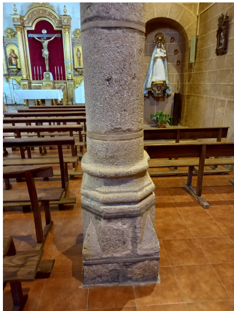
Detalle de los pilares prismáticos
