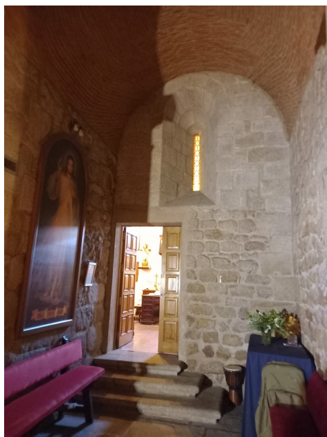
Acceso a la sacristía
