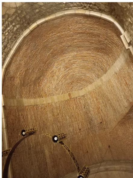
Cubierta de la capilla mayor
