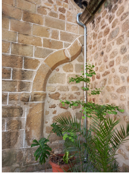
Puerta cegada, de estilo gótico, que se abre en arco conopial
