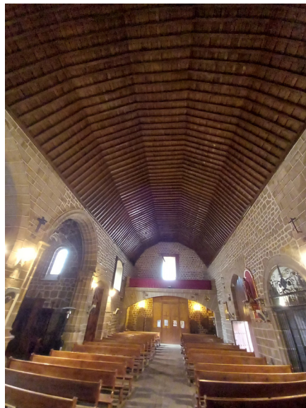
Nave y cubierta
