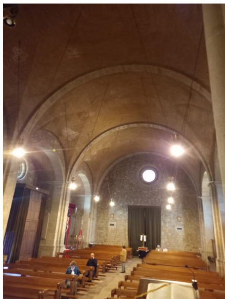
Interior del templo
