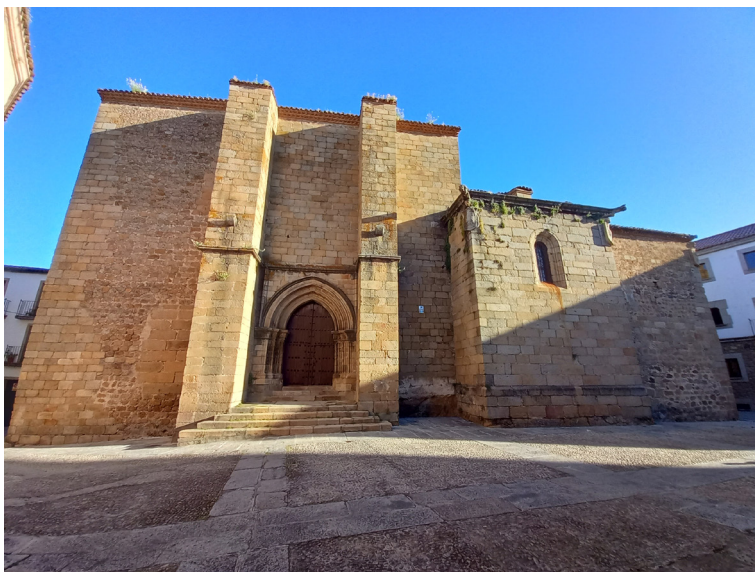
Fachada sur de la iglesia
