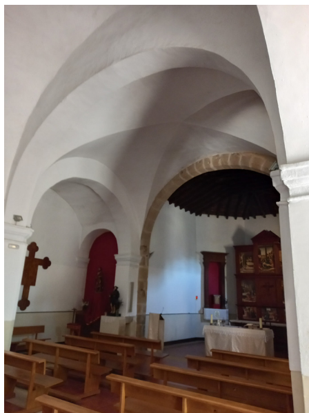
Detalle de las bóvedas
