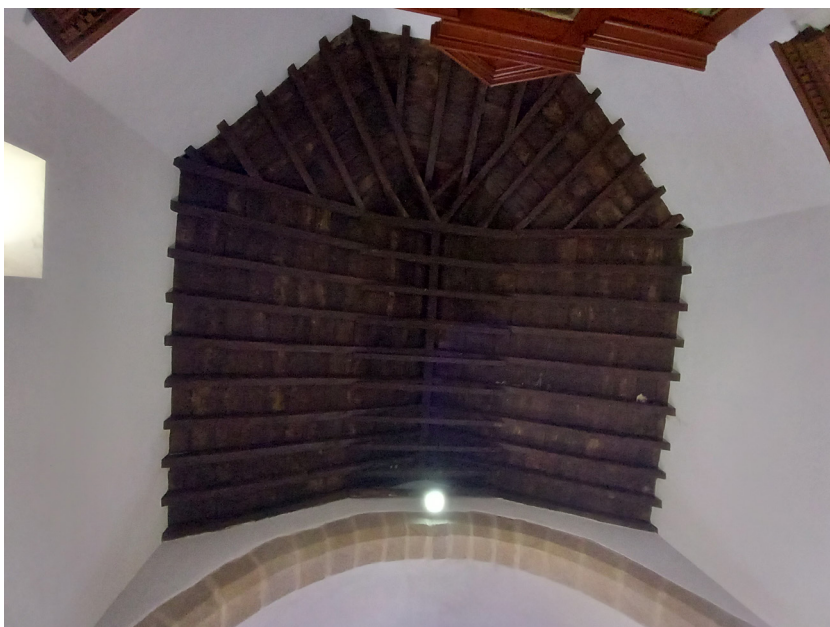
Cubierta de la capilla mayor. Artesonado mudéjar
