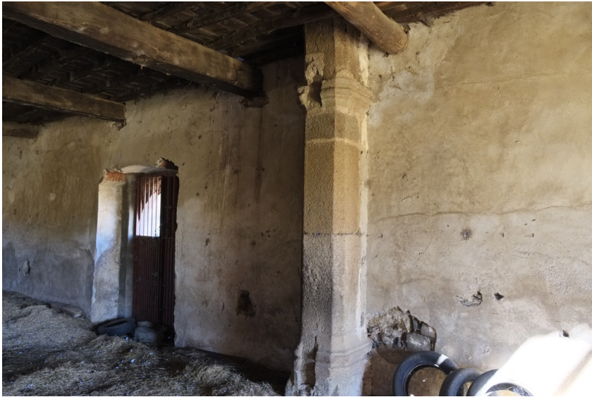
Restos de columnas
