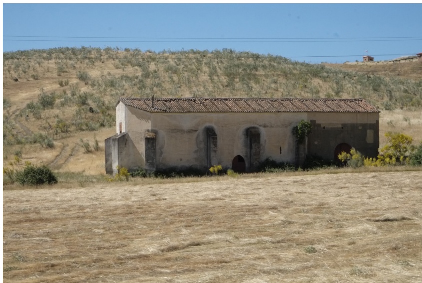
Vista general y detalle de los contrafuertes
