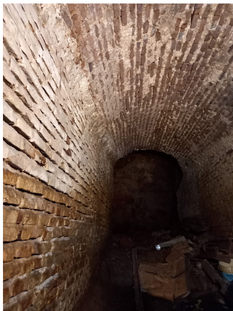
Acceso desde la sacristía al exterior. Contacto con los lacerados
