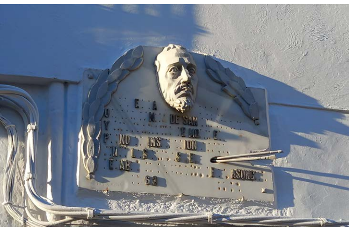
Detalle de la fachada de la ermita
