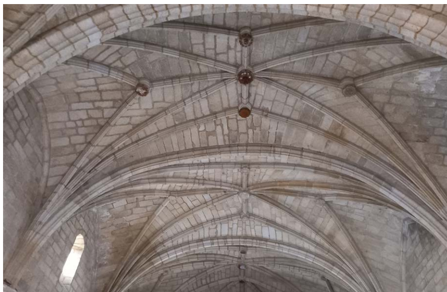
Bóvedas de la nave
