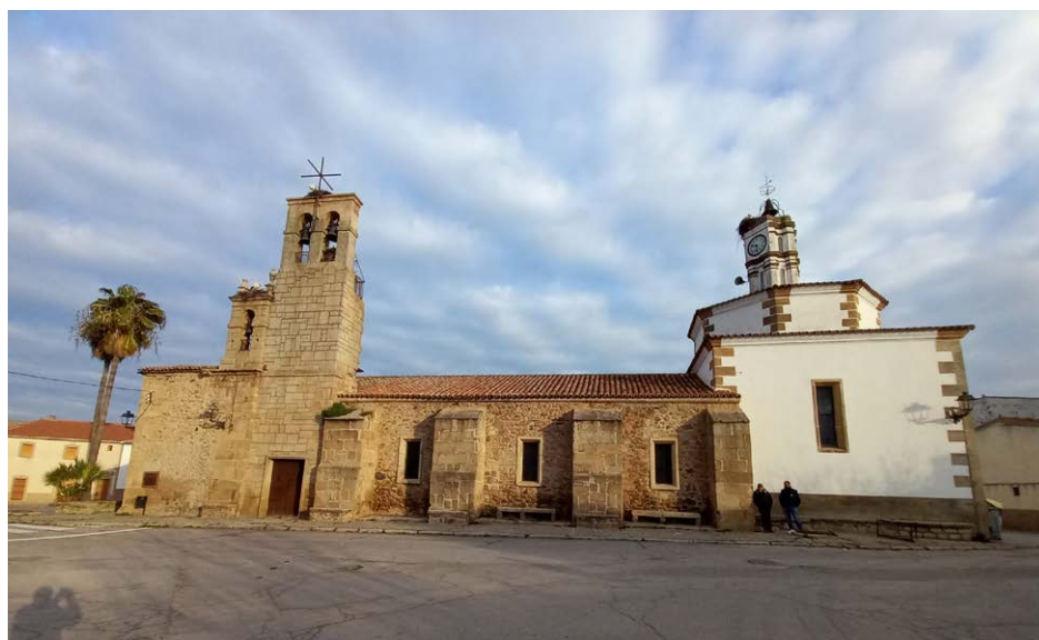
Vista exterior, capilla mayor y cúpula
