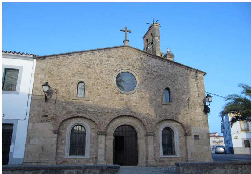
Detalle de la fachada de los pies
