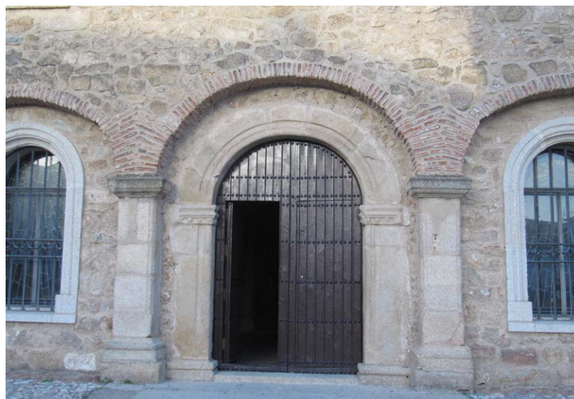
Pórtico de acceso
