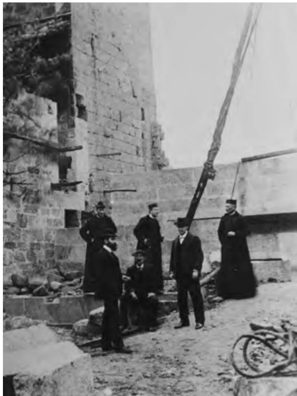
Obras de traslado da Igrexa de San Francisco
