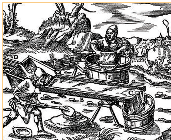
Figura 6.- Grabados sobre trabajos con minerales metales (Agricola).
