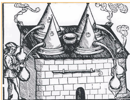
Figura 3.- Aparato para destilar con conos metálicos
