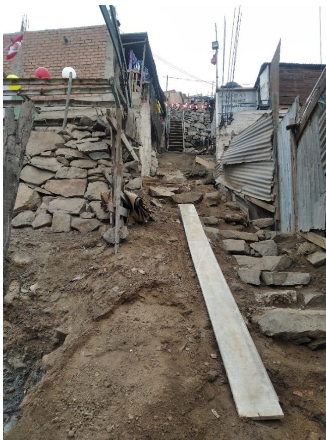
FIGURA 6. Infraestructura de movilidad improvisada en el Asentamiento Humano Villacanta, Independencia
