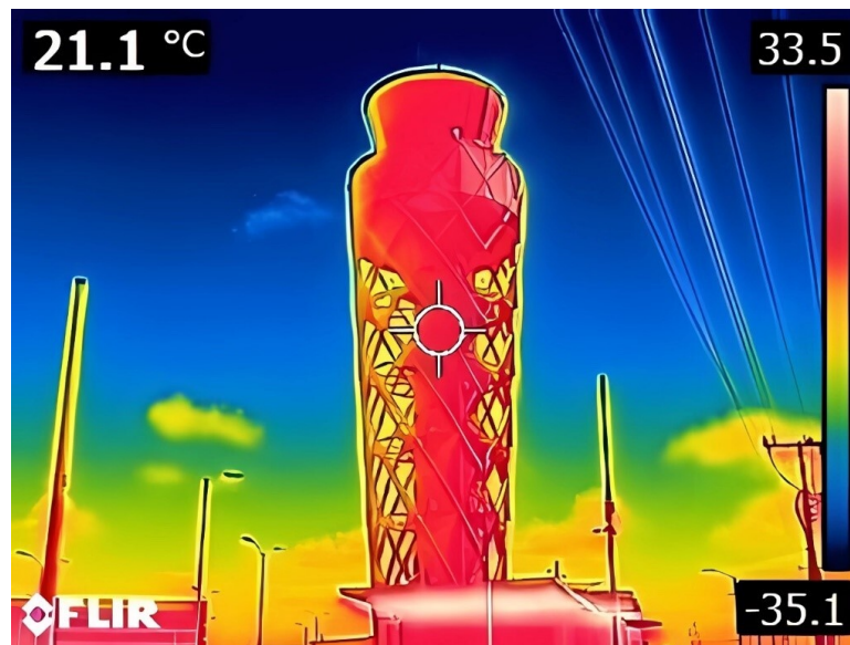
Figura 1. Termograma torre de control Aeropuerto el Dorado Bogotá
