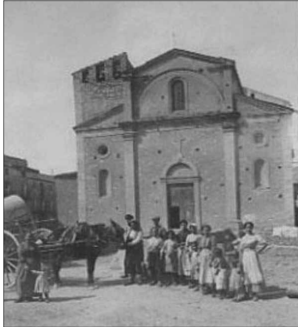
Façana de l'església de Pira
