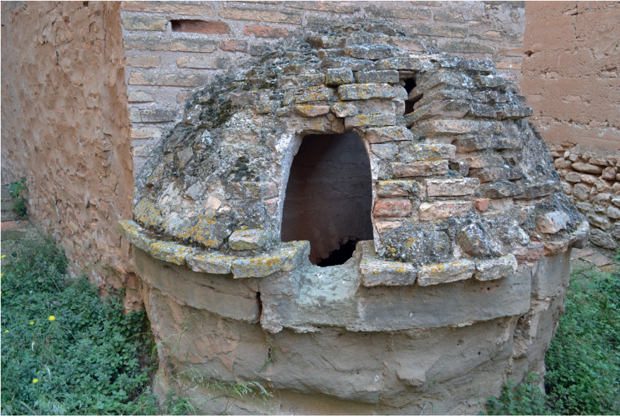
Pozo situado en el patio de recogida de aguas.
