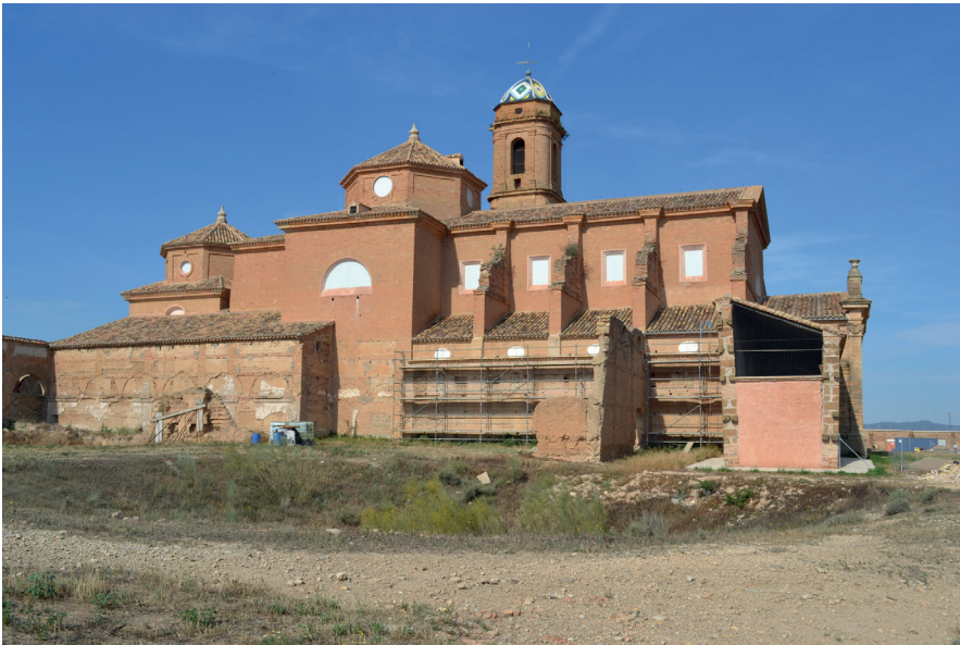
Vista lateral del monasterio, con los arcos tapiados del segundo claustro y los andamios de las obras de consolidación de la pared.
