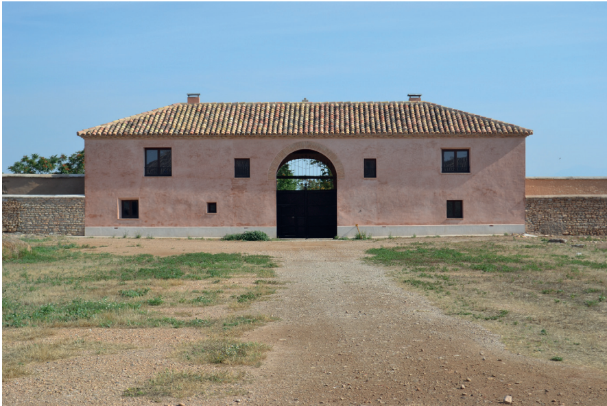
Edificio de la portería, utilizado como centro de acogida de los visitantes.
