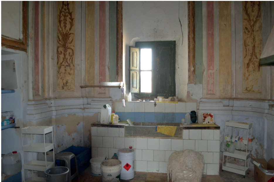
Estado actual de la antigua capilla del prior.
