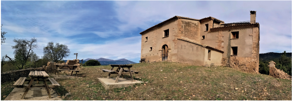
Vista de la ermita desde el sureste.
