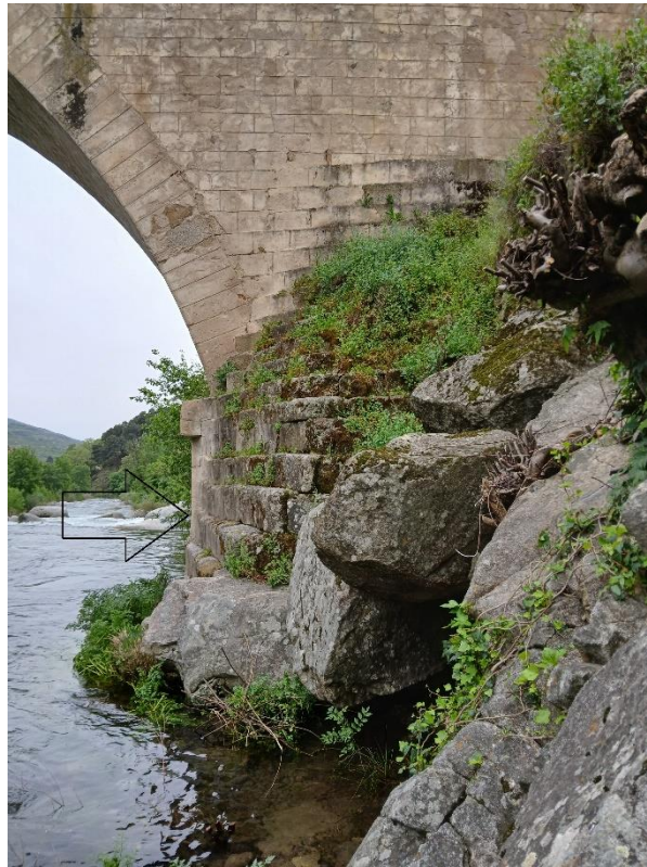
Fig. 3. Detalle de los bloques de granito en uno de los arranques (bases) del puente de Cabezuela, junto al cauce del río Jerte
