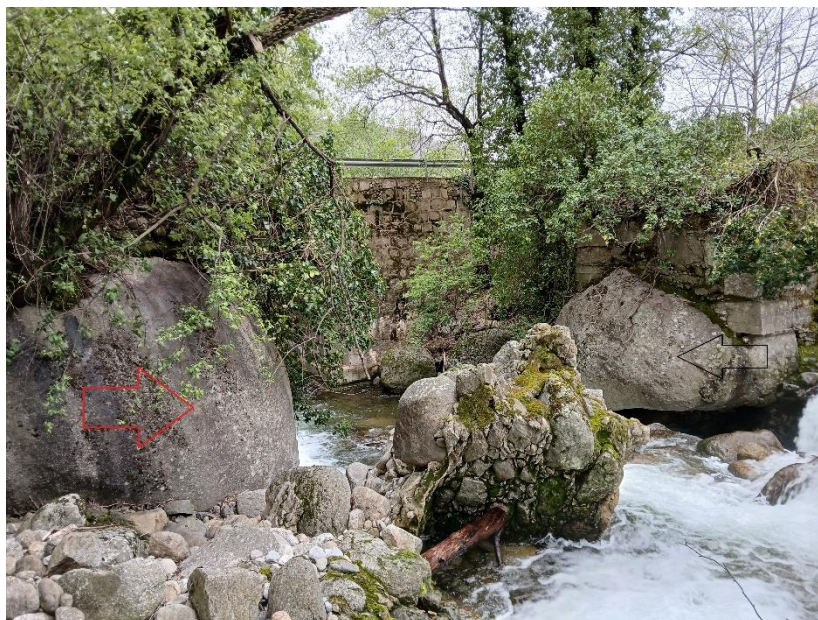
Fig. 4. Restos del antiguo puente sobre la Garganta Becedas. Dos grandes rocas, situadas en el cauce de la Garganta, se utilizaron como machones para edificar el puente.
