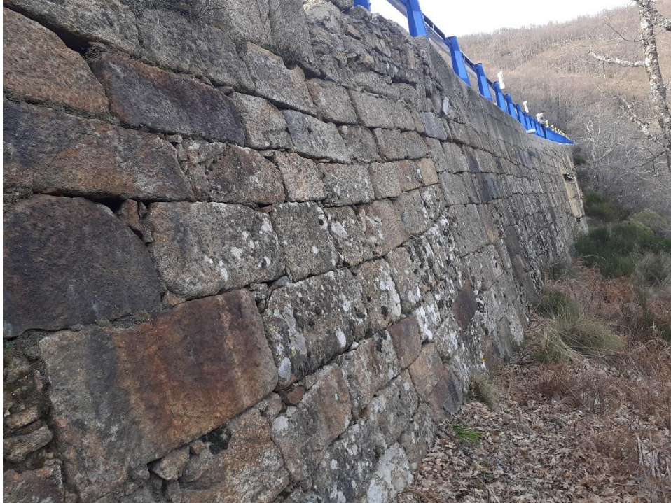
Fig. 5. Muro de contención realizado en el Puerto de Tornavacas. Destacan los característicos bloques rectangulares de granito utilizados en su construcción
