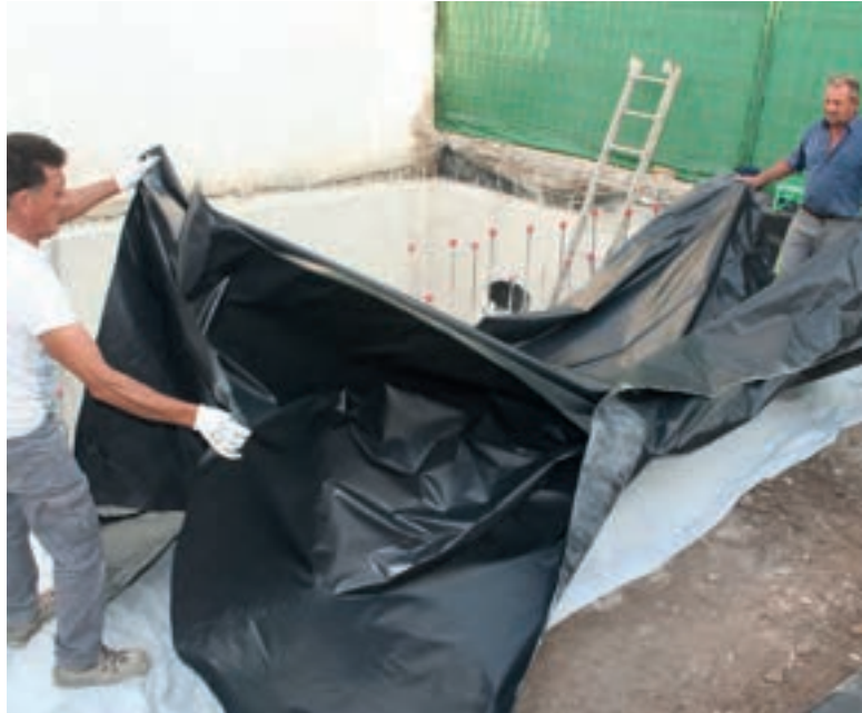
C/ Real, 55. Protección de estructuras medievales.
