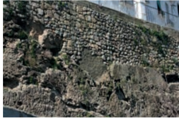
Tajo del Adarve. Reintegración puntual de pérdidas de fábrica y roca.
