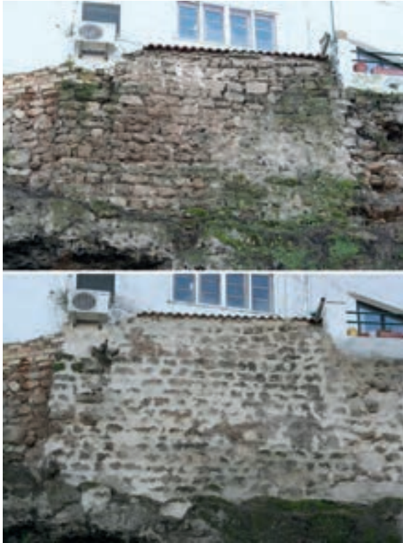
Tajo del Adarve: c/ Adarve, 2 (traseras). Restitución del mortero erosionado.
