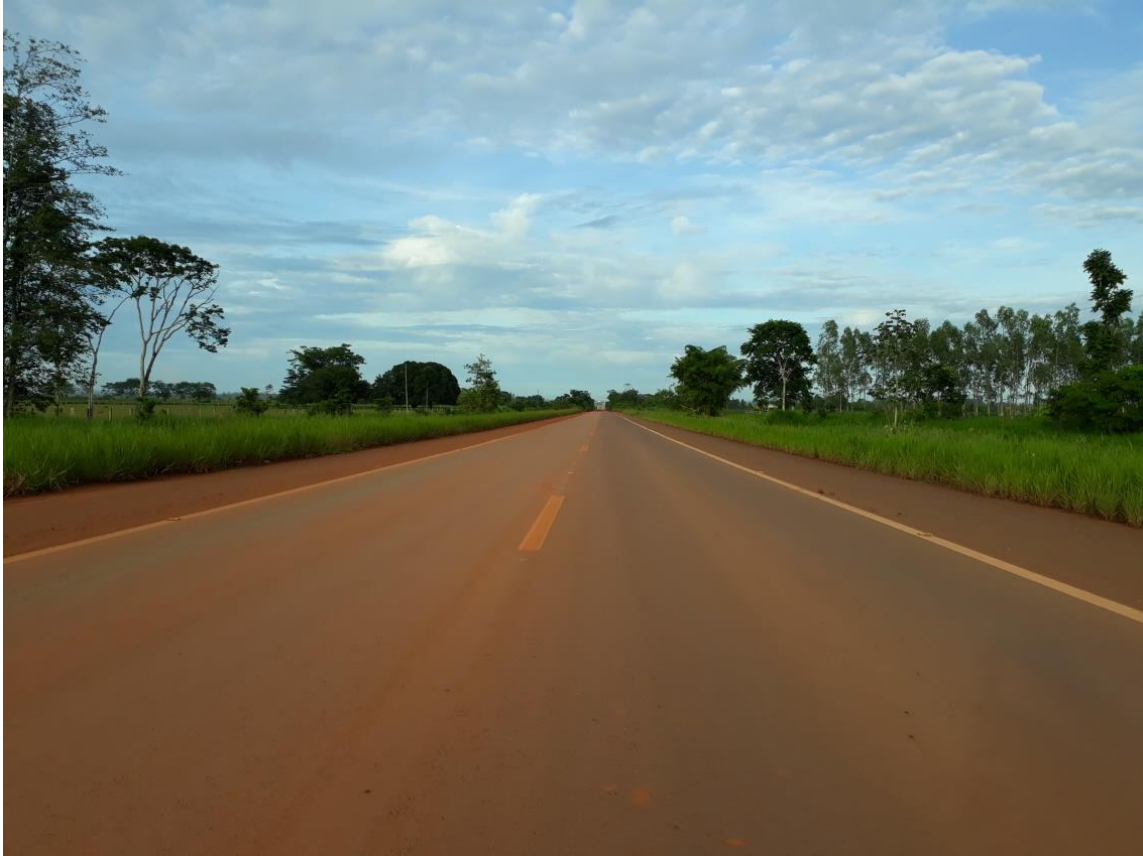
Figura 3. Foto da Rodovia federal 429 em São Francisco do Guaporé/RO
