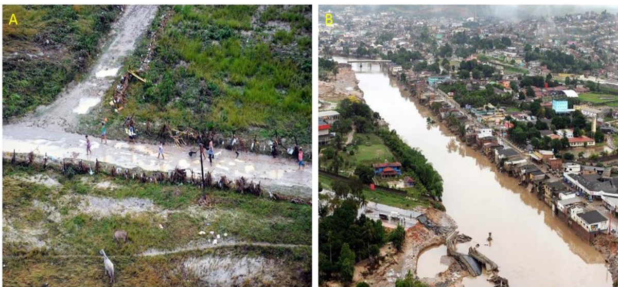
Figura 7. (A) Pessoas saindo de suas residências em razão das chuvas em Palmares/PE (19/06/2010); (B) Proximidade da ocupação do solo (residências) em relação às margens do Rio Uma em Palmares/PE.
