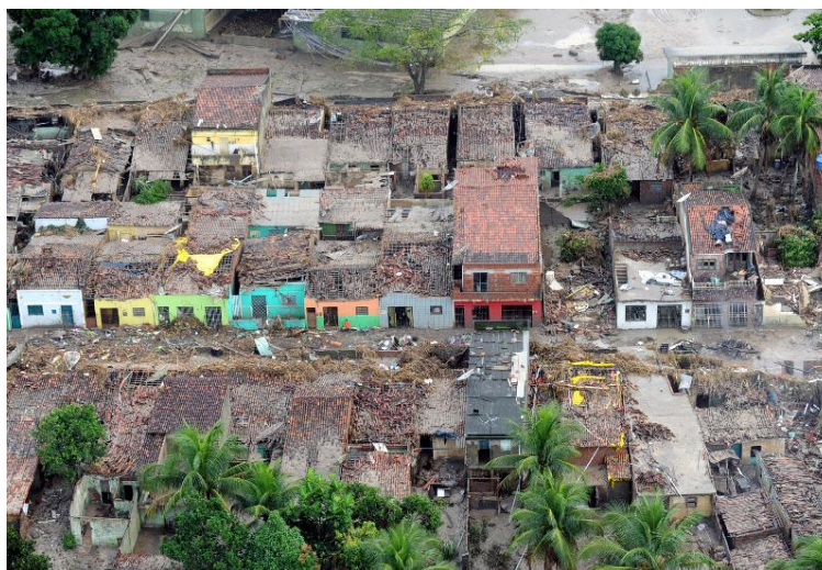
Figura 3. Residências destruídas após a enchente do Rio Una em Palmares/PE.
