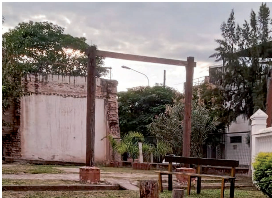
Figura 5. Sector de la casa que fue demolido. Foto de las autoras.
