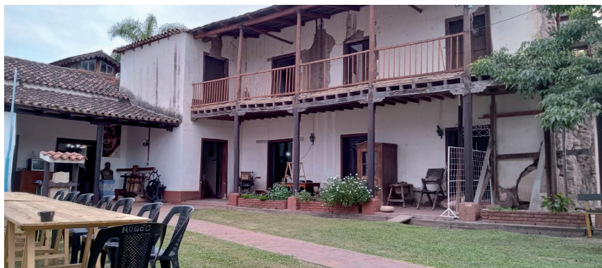
Figura 4. Vista parcial del edificio tomada desde el patio externo. Foto de las autoras.
