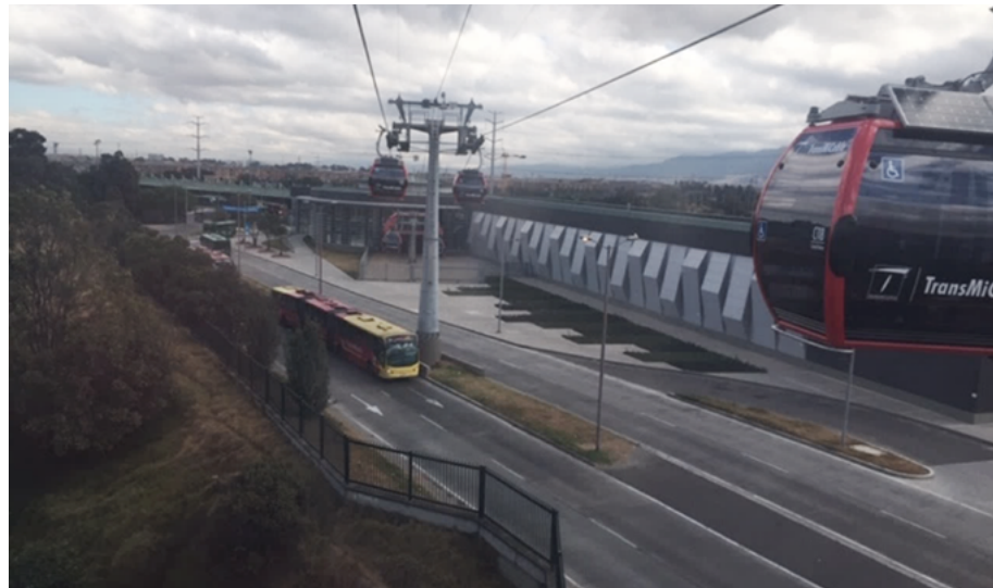
Figura 7. Portal Tunal: integración modal entre el TransMilenio y el cable aéreo
