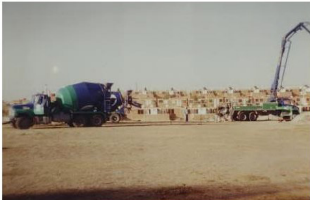
Figura 6. Colado del bloque de cimentación
