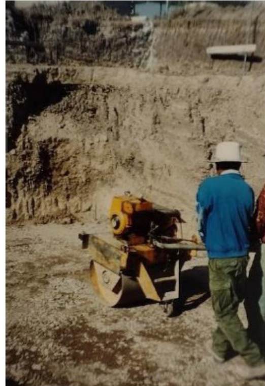
Figura 4. Compactación de la capa base (grava – arena)
