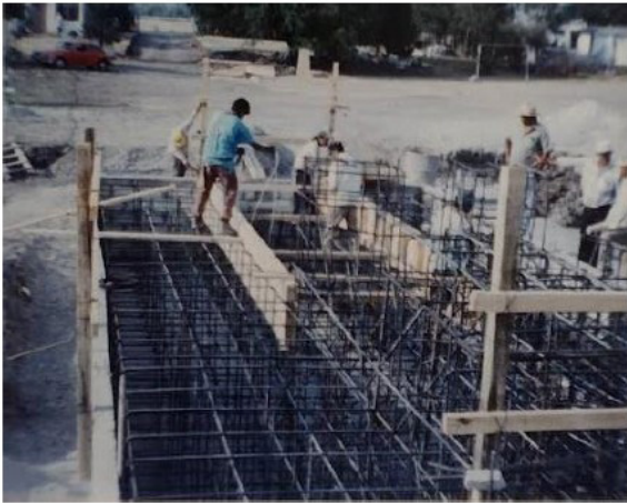
Figura 5. Acero de refuerzo bloque de cimentación
