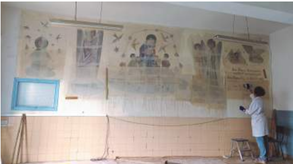
Extracción de las pinturas del aula por la directora Blanca Sagasti.
