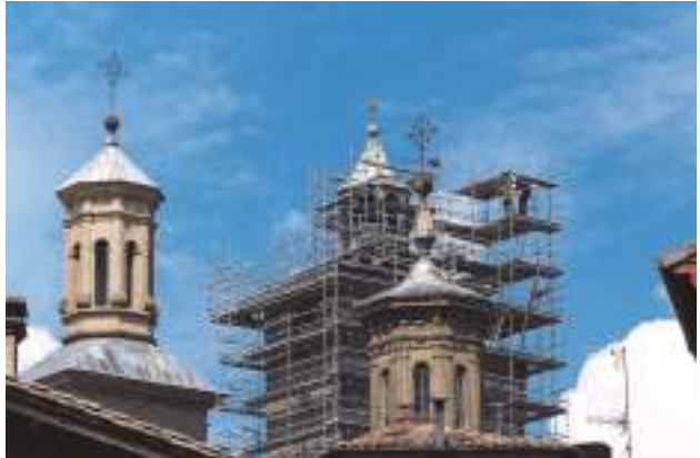
Chapiteles de San Saturnino con el andamio a punto de coronar el Gallico de San Cernin.
