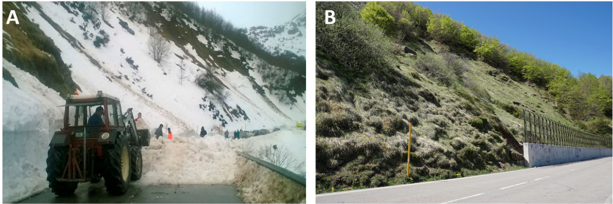
Figura 5. Imágenes de un sector de las Curvas del Nisaléu. A. Maquinaria y personal trabajando en la limpieza de la carretera tras la caída de aludes. B. Barrera de protección de la carretera instalada posteriormente en el mismo punto.
