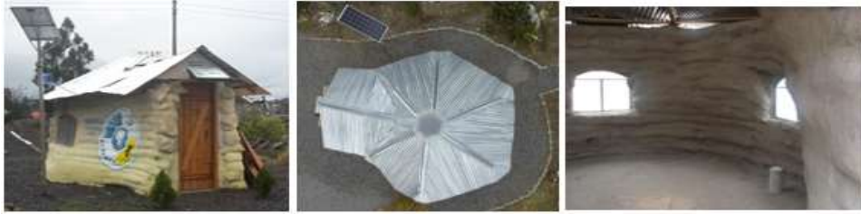
Figura 1 Superadobe en la ciudad de Riobamba, en el campus Msc. Edison Riera de la UNACH.
