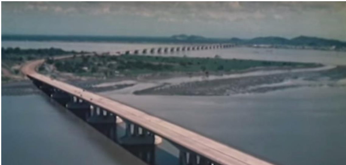
Fotografía del Puente de la Unidad Nacional 1970. Recuperado de: https://www.eluniverso.com/noticias/2015/09/14/nota/5126219/video-asi-se-construyo-puente-unidad-nacional-1967-1970/
