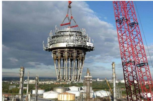
Figura 1. Operación de izamiento de cabezal de un regenerador usado en una refinería de petróleo.
