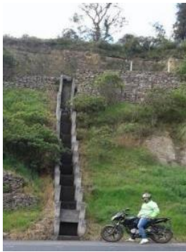
Figura 3. Estructuras de disipación (prototipo) con canal escalonado. Fuente: [9].
