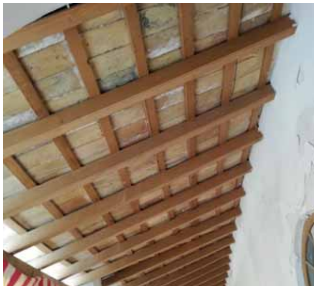
ANTIGUO CLAUSTRO DEL CONVENTO DE LOS DOMINICOS, HOY CLUB SOCIAL. USO DEL LADRILLO DE RASILLA O ALFAJÍA SOBRE RASTRELES PARA APOYAR LA CUBIERTA. IMAGEN DEL AUTOR, 2022.
