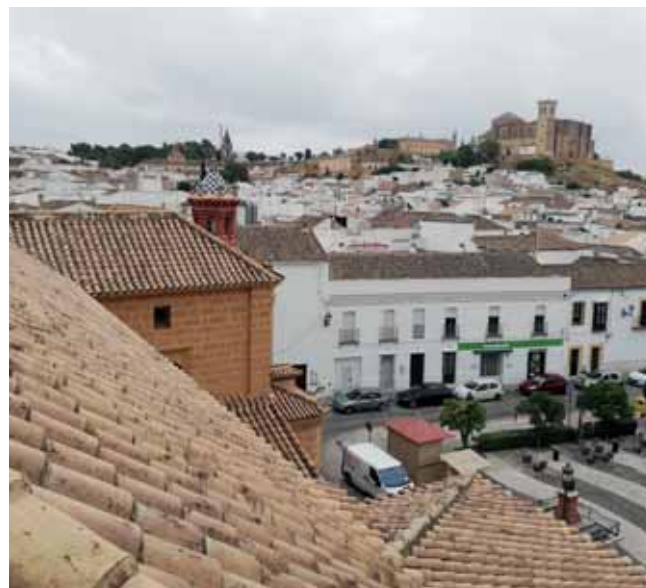
DETALLE DE LAS CUBIERTAS DE SANTO DOMINGO, UNA DE LAS MÁS COMPLEJAS Y DE MAYOR VISTOSIDAD DE LA CIUDAD DE OSUNA. EN SU RECIENTE REHABILITACIÓN LAS CUBIERTAS TENÍAN IMPORTANTES DAÑOS ESTRUCTURALES. FUERON REHABILITADAS INTEGRALMENTE Y SE UTILIZARON TEJAS ANDALUZAS ANTIGUAS, LAS CAMBUJOS Y LAS SOLERAS. DADA LA FUERTE PENDIENTE DE ESTAS CUBIERTAS, LAS PIEZAS ESTÁN AMORTERADAS. PARA EVITAR ROTURAS PRODUCIDA POR LA RIGIDEZ DEL CEMENTO SE UTILIZARON MORTEROS CON CAL, MÁS FLEXIBLES QUE LOS CONVENCIONALES. IMAGEN DEL AUTOR, 2022.
