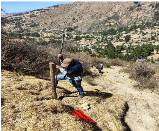
Figura 16. Colocación de señaléticas
