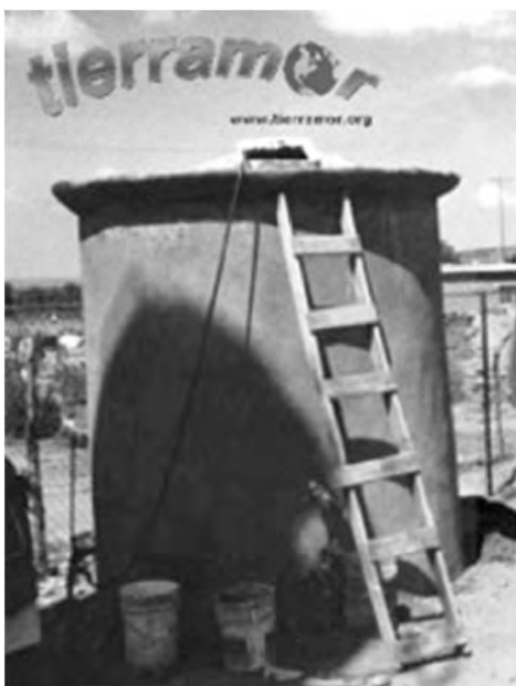
Imagen 2. Cisterna de Ferrocemento
