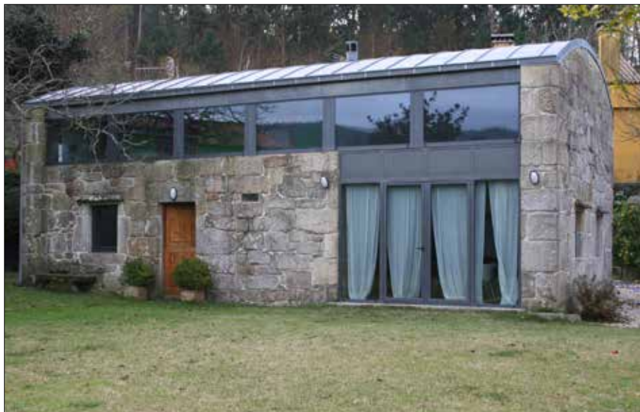
Vista xeral dende o nordés. As agullas, tranqueiros, lintel e peitoril da ventá que existía no pano acristalado foron trasladados para un novo oco da fachada de poñente.
