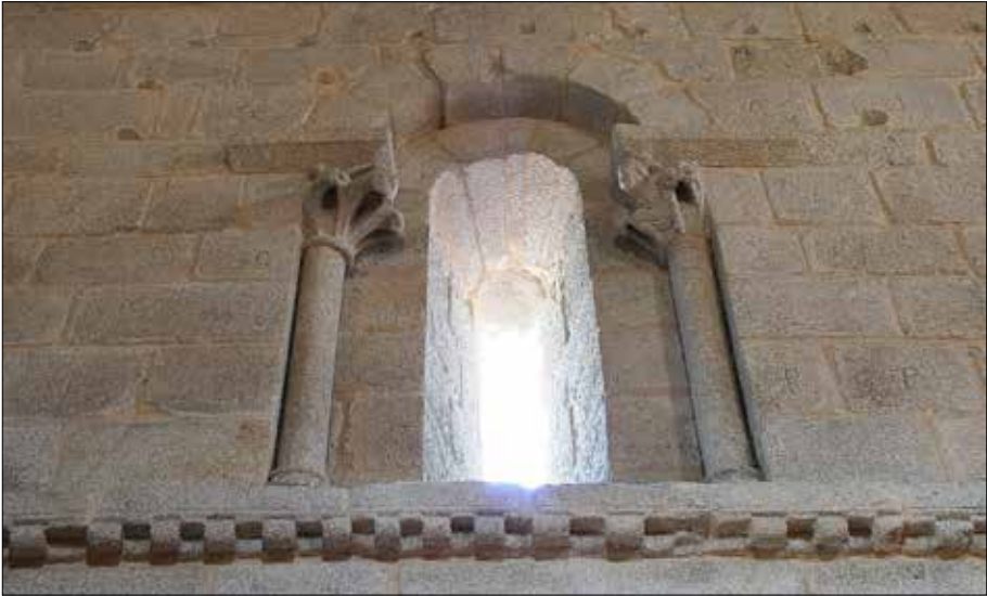
Ventá íntegra sobre imposta de billetes no muro meridional da nave.
