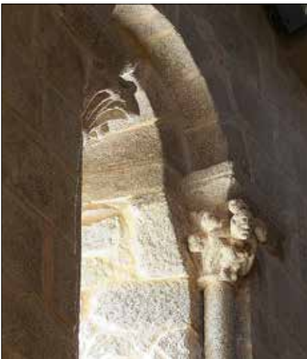
Ventá retocada no muro meridional da nave.
