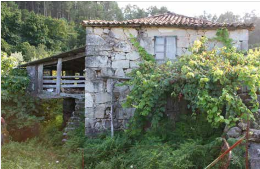
Casa da Guincha, no Pereiro, unha fermosa tipoloxía patín-corredor necesitada de urxente rehabilitación. Donas.
