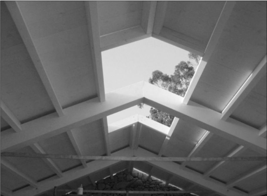
Obras de rehabilitación da cuberta. Foto de J.M. Costas.
