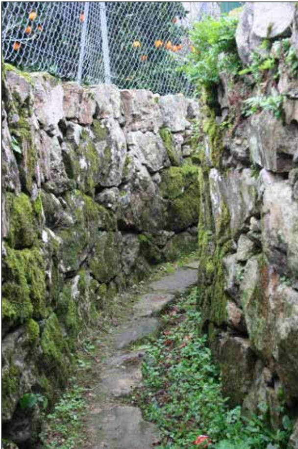
Carreiro da Vicentiña, entre muros de peche de leiras, con pavimento de lousas para camiñar (pasal) e rego para auga, hoxe cheo de terra pola perda do uso. Moi preto do caleixón das Laxes. Donas.
