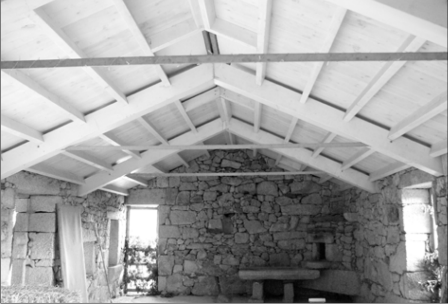
Vista interior da casa vernácula en obras.
