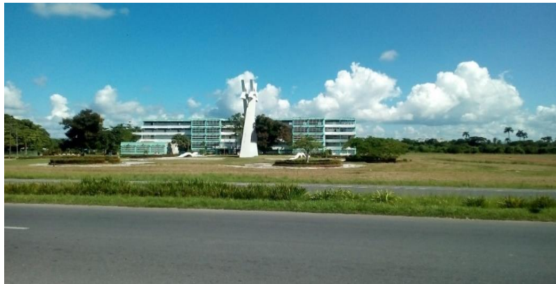
Figura 1. Vista frontal del bloque docente de la sede "Hermanos Saíz Montes de Oca". Universidad de Pinar del Río. Figure 1. Front view of the teaching block of the "Hermanos Saíz Montes de Oca" branch. University of Pinar del Río.
