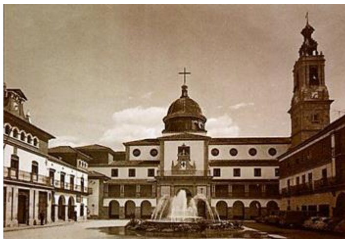
Figura 18. Imagen de la plaza Mayor de Nules. Fuente: Revista Reconstrucción .
