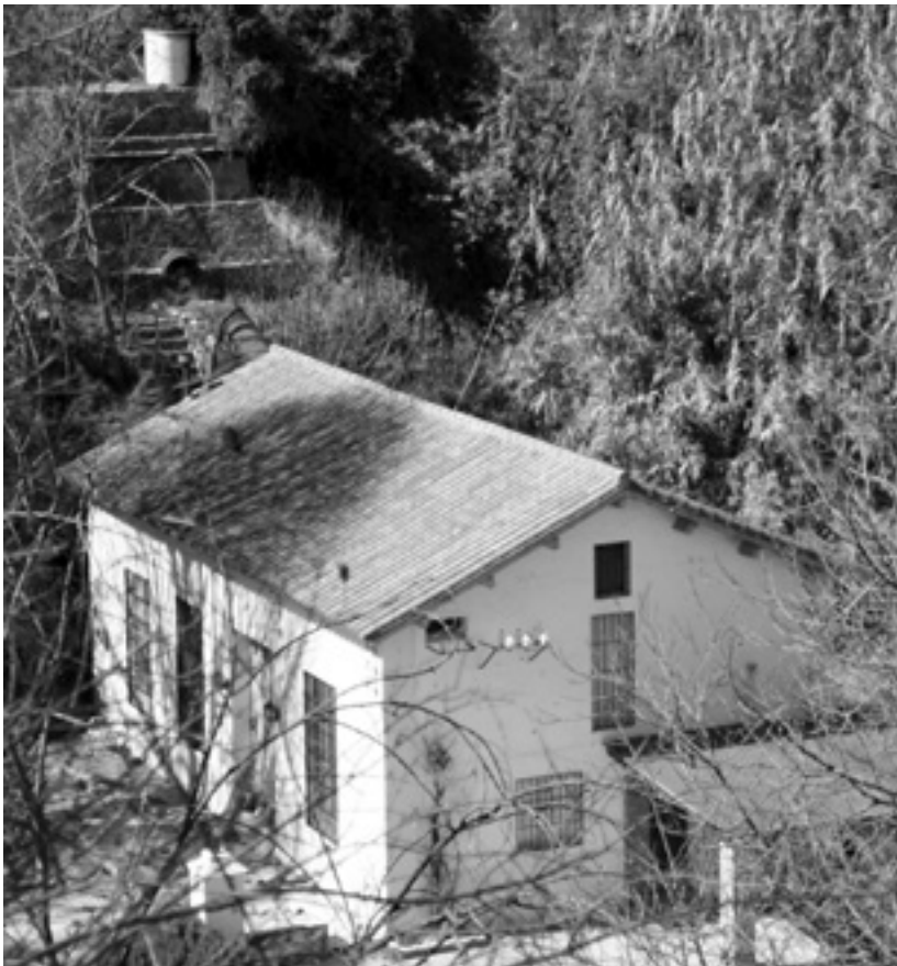
Fig. 20: Hidroeléctrica Santa Teresa de Coín con vista de la cámara de carga, tubería forzada y edificio de la central. Manuel Bermúdez Méndez (2017).
