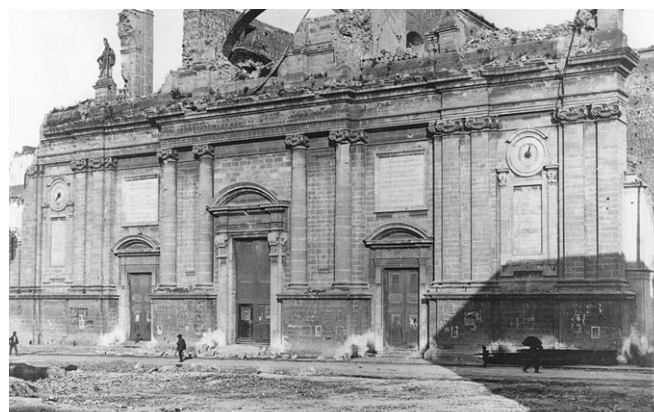
Fig. 5. Messina. Chiesa della Maddalena dopo il terremoto del 1908.
