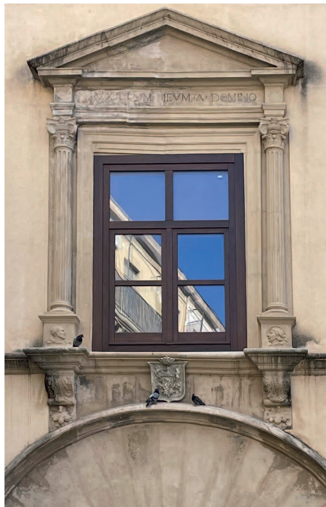
Fig. 1. Palermo. Palazzo Scavuzzo, finestra della facciata, 1547.
