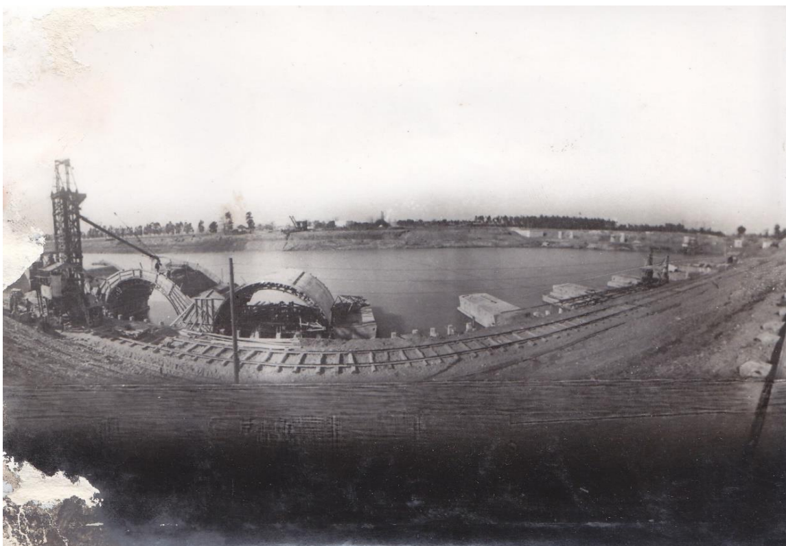
Figura nº 4: obras de ejecución del muelle de Tablada, sobre la corta del mismo nombre.
