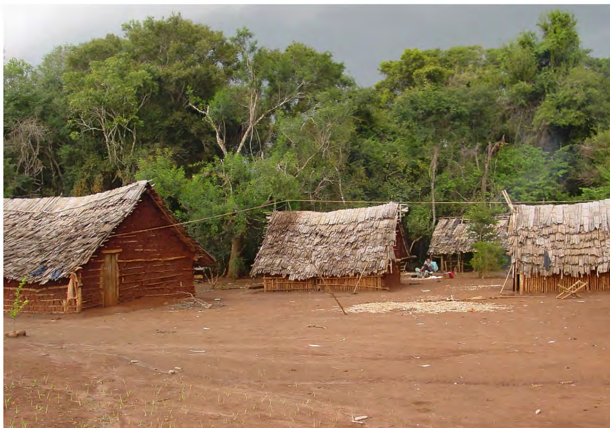
Figura 1. Conjunto de moradias e opy , Tekoá Koenju. As construções possuem as cores da terra utilizada como fechamento das paredes. As coberturas e as estruturas são compostas por espécies vegetais locais, com significado simbólico. Fonte: Zanin, 2006.
