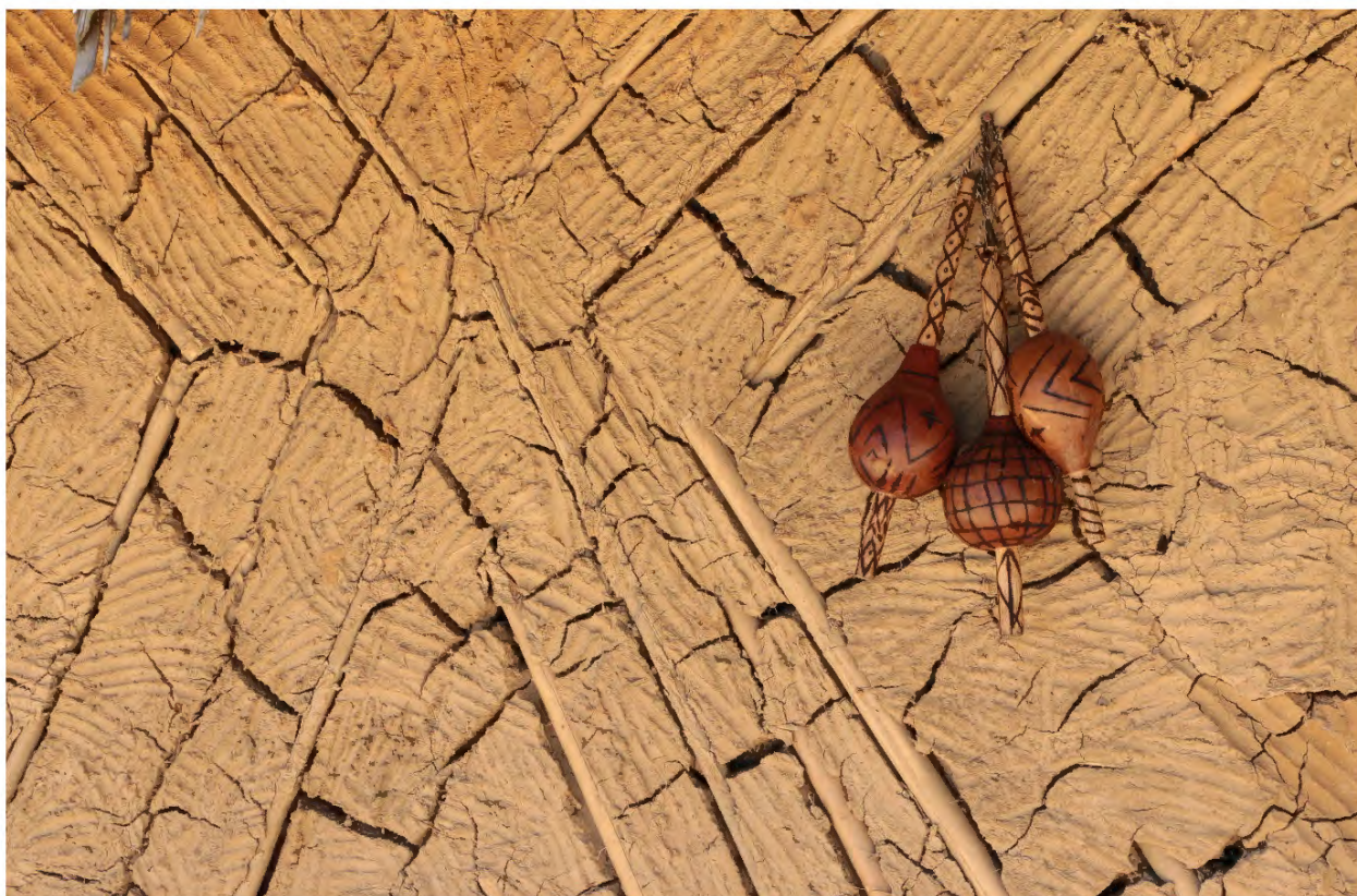
Figura 4. Detalhe da parede da opy do Tekoá Vy'a, em terra crua de tonalidade clara, devido à proximidade com o litoral. Podem ser observadas as marcas deixadas pelos dedos que alisaram a parede, uma característica do processo construtivo tradicional guarani. Fonte: Zanin, 2021.
