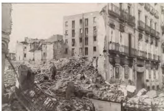
Madrid, febrero de 1937. Estado en que quedó el barrio de Argüelles, tras el bombardeo de la aviación nacional. Fotografía: Piortiz
