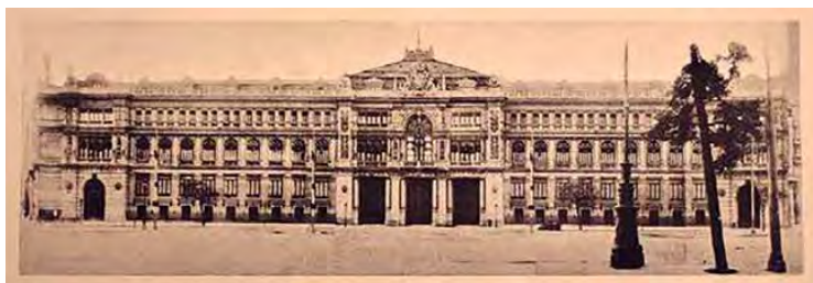
Madrid. Fachada de la calle de Alcalá del edificio del Banco de España. Arriba, a la derecha, las casas de Santamarca antes de su demolición. Abajo, después de la ampliación realizada entre 1929 y 1936. 1936. Fotógrafo (probable), Antonio de Zárraga.
