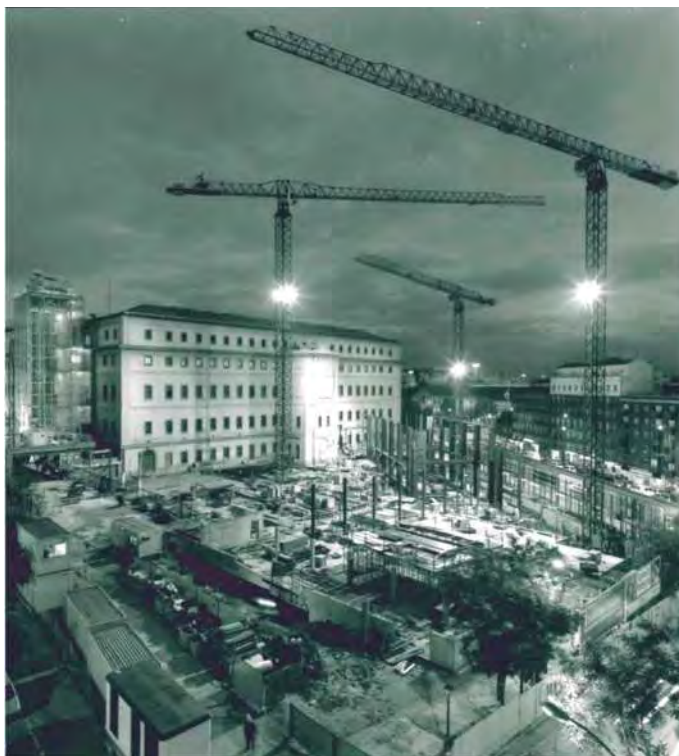
Fondo Ana Muller. Obras de ampliación del Museo Nacional Centro de Arte Reina Sofía. Madrid 2001-2004. Signatura 918942.1
