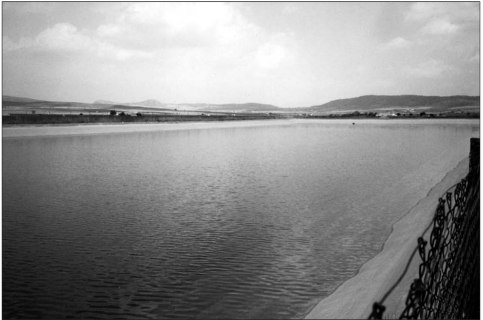
Figura 11. Depósito de agua al aire libre para riego.
