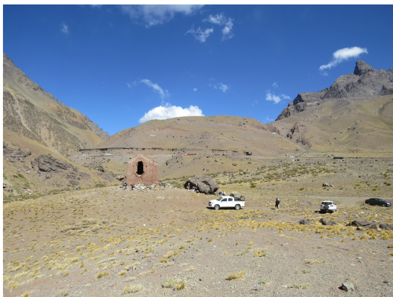
Figura 2. Vista general de la Casucha de Paramillo de Las Cuevas, vista hacia al oeste. Al norte del refugio se observan los bloques rocosos donde se encuentran los aleros NW y NE
