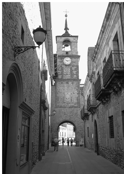
La torre del Reloj de Ponferrada se construyó a principios del siglo XVI, siendo reedificada en 1567 y 1594. Constaba inicialmente de dos cuerpos levantados sobre el arco de medio punto. En el cuerpo inferior tiene un escudo y en el superior está el reloj. En 1693 se proyectó hacer el campanario, pero las obras no se llevaron a cabo hasta un siglo más tarde.
