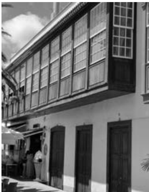
Fachada trasera hacia la Avenida Marítima de la antigua sede de la S. D. Tenisca
