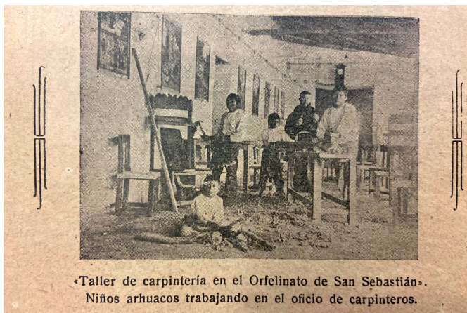
Foto 7. Taller de carpintería. Fuente: Soler y Royo (1925, p. 131).
