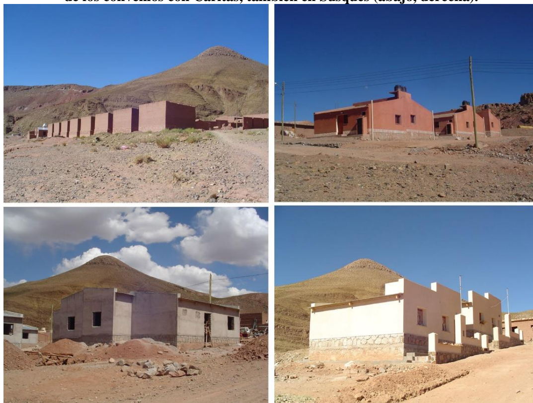
Figura 5. Primer plan de viviendas en Susques (arriba, izquierda); conjuntos emergentes de los Planes Federales (arriba, derecha y abajo izquierda) y las viviendas construidas en el marco de los convenios con Caritas, también en Susques (abajo, derecha).
