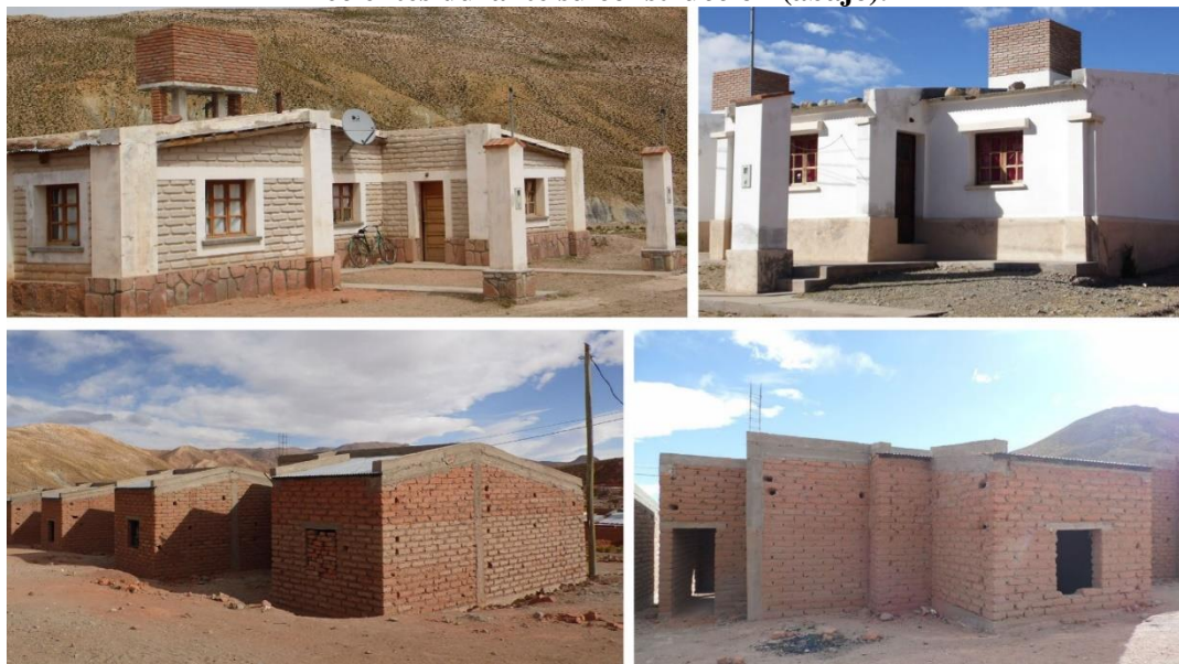
Figura 4. Primeros planes de vivienda ejecutados en Coranzulí (arriba), y planes más recientes durante su construcción (abajo).
