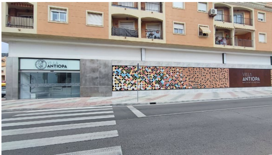
Figura 1. Vista de la fachada sur, con la entrada principal y ladrillos imitando a las teselas
