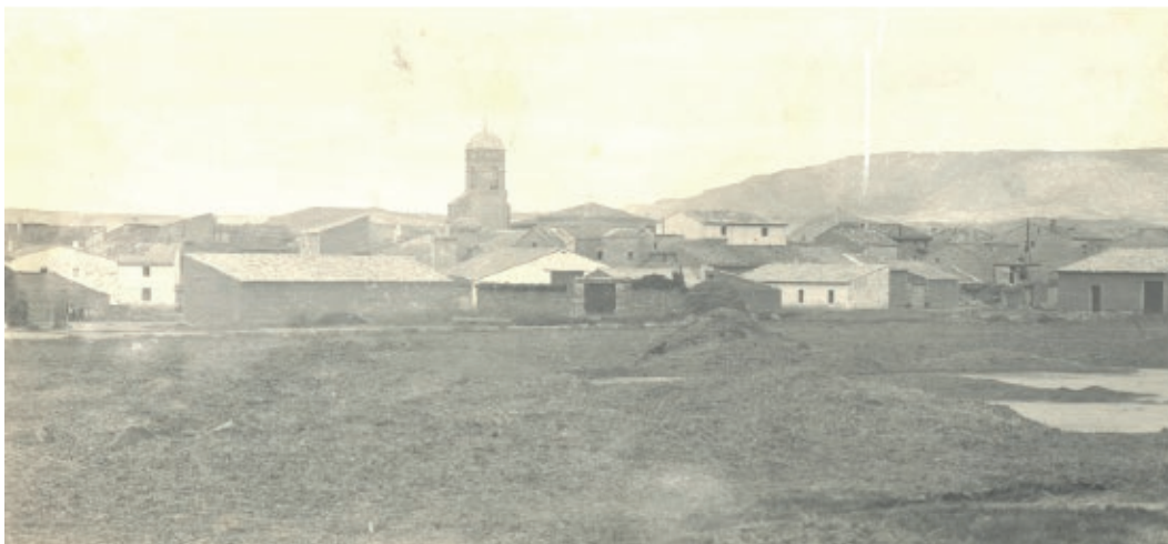
Panorámica de Carcastillo en 1905 con la torre parroquial recién construida emergiendo sobre el caserío. AMP, Fototeca 003216, Colección municipal, Roldán e hijo.
