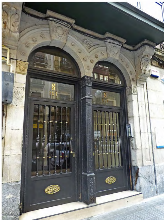
Fig.2. Detalle de la entrada de la casa de vecindad de Ramón Mestraitua, Bernardo Careaga y Pedro Alonso. Arquitecto Julio Saracíbar. 1886. Calle Fernández del Campo n os 8 exterior y 8 interior. Bilbao
