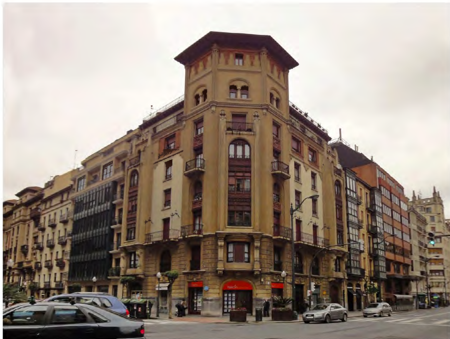
Fig. 6. Casa de Santiago Arana . Arquitecto Ignacio Smith Ibarra. 1925. Calle Alameda Recalde nº 22. Bilbao
