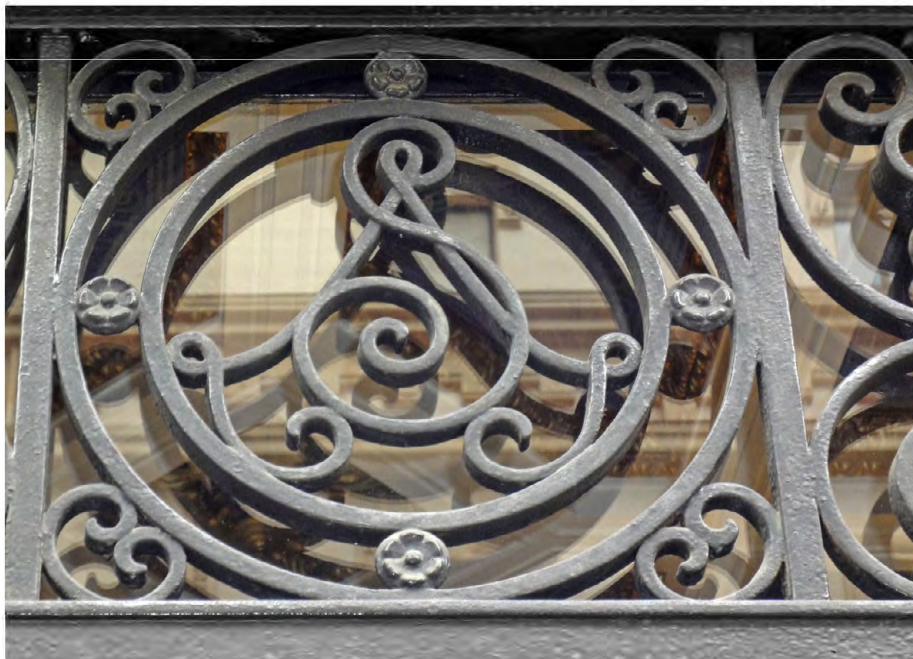
Fig. 7. Montante de la puerta del portal de la casa de Santiago Arana. Arquitecto Ignacio Smith Ibarra. 1925. Calle Alameda Recalde nº 22. Bilbao
