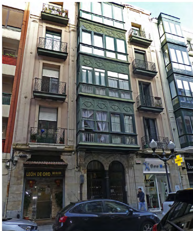
Fig. 1. Casa de vecindad de Ramón Mestraitua, Bernardo Careaga y Pedro Alonso. Arquitecto Julio Saracíbar. 1886. Calle Fernández del Campo n os 8 exterior y 8 interior. Bilbao
